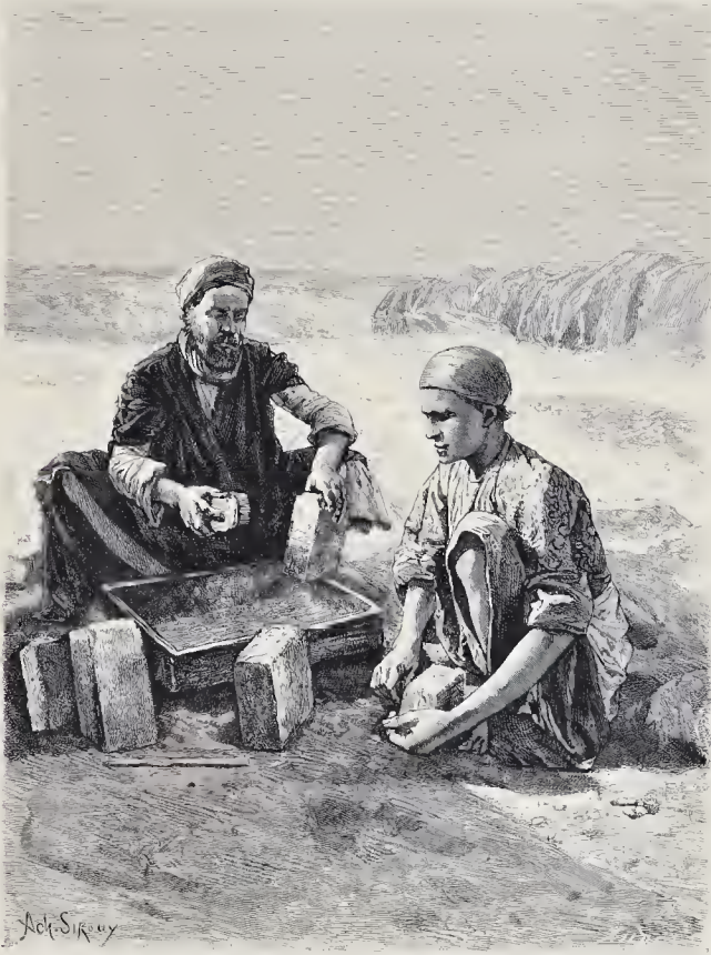
LAVAGE DES BRIQUES.
