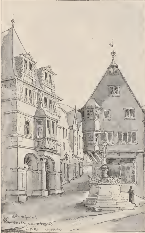
Marktplatz in Bernkastel. Aufgenommen von Architekt H. Goerke in Düsseldorf.
