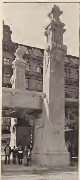
Elektrische Hoch- und Untergrundbahn in Berlin. 1. Pfeiler zur Ueberbrückung der Potsdamerstrasse. Architekt: Prof. Bruno Möhring in Berlin. Steinmetzarbeit von Carl Schilling daselbst.
