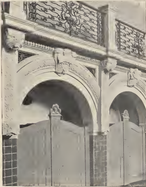
Volksbad in der Bärwaldstrasse in Berlin. Architekt: Stadtbaurat Ludwig Hoffmann in Berlin. 2. Detail der Schwimmhalle.
