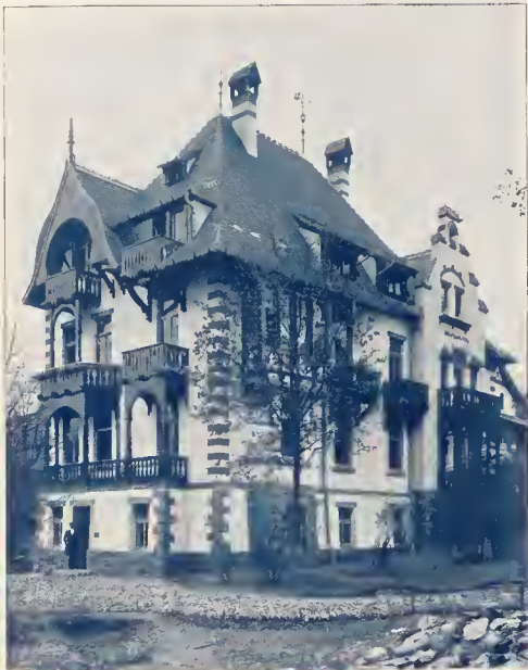
Die Albertparkvilla in Bad Elster.
