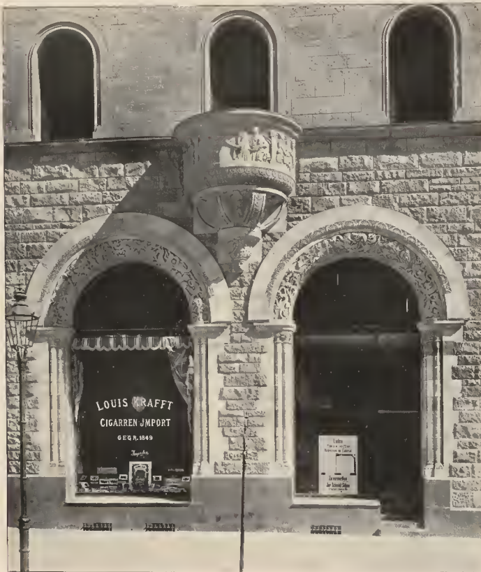
Das neue romanische Haus in Berlin. 4. Schaufenstergruppe und Balkon an der Tauenzienstrasse.
