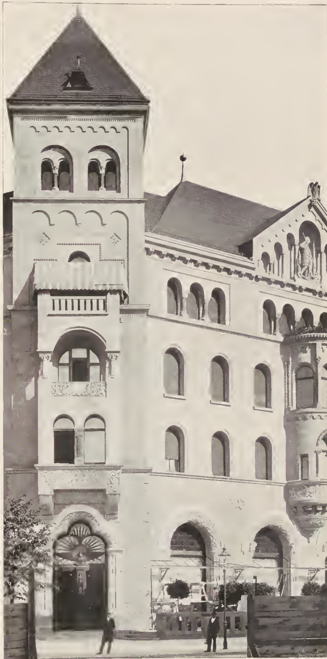
Das neue romanische Haus in Berlin. S. Ecke am Kurfürstendamm. (1—7 im Textblatt.)
