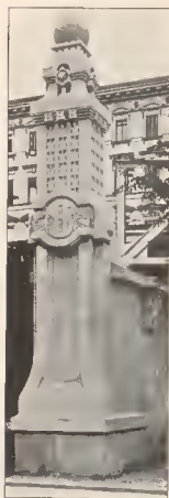
Pfeiler am Dennewitzplatz.
