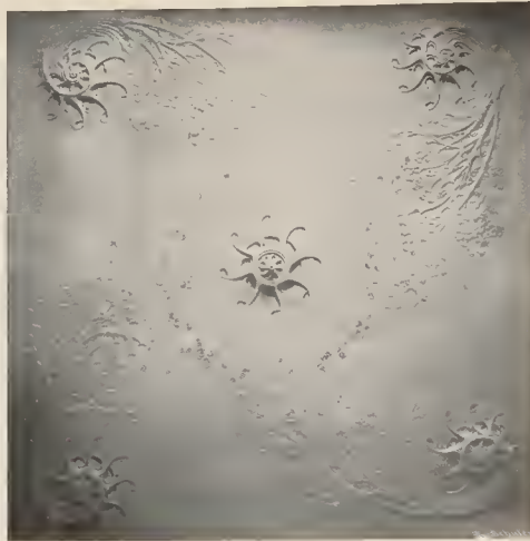
Stuckdecke im Raum 30.
