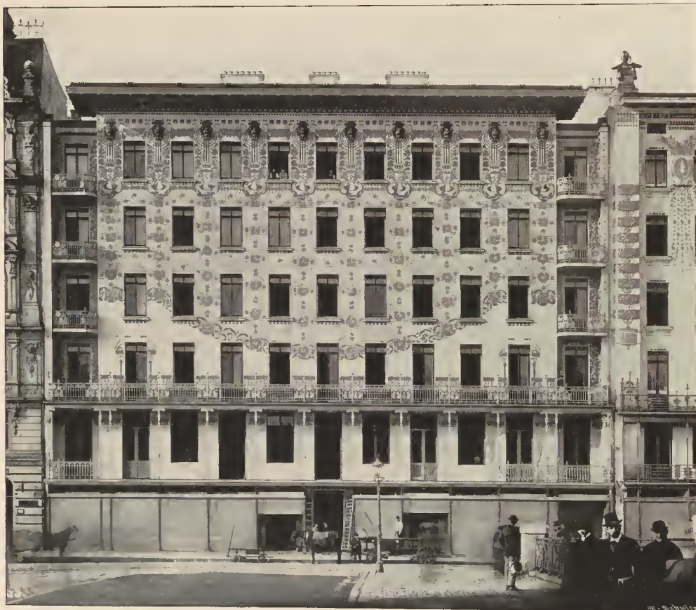
Wohn- und Geschäftshaus in Wien V, Woltzeile.
