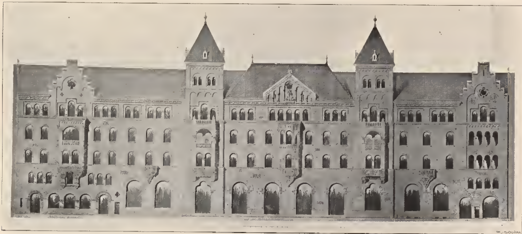
Kurfürstendamm. Das neue romanische Haus in Berlin. 1. Abgewinkelte Gesamtansicht.
