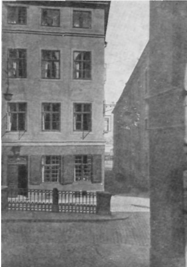
5. Utanför Källaren Freden
