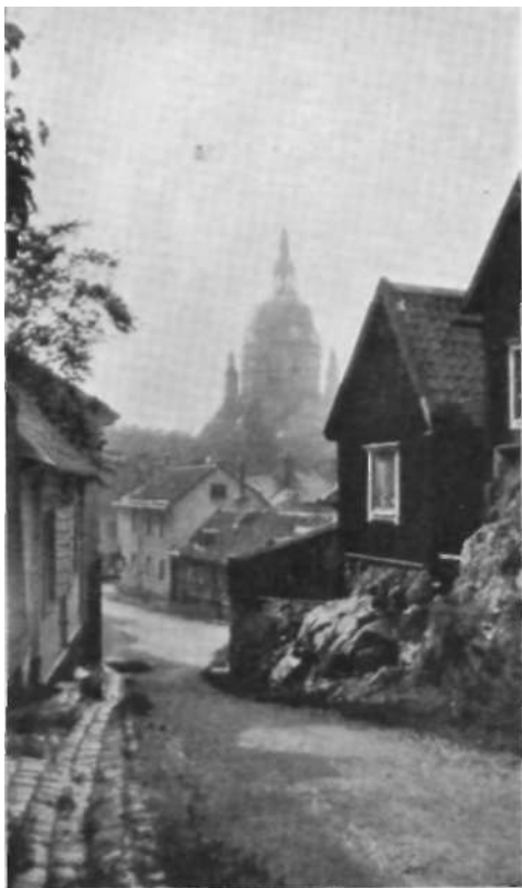
98. Från Stigbergsgatan väster om uppfartsvägen
