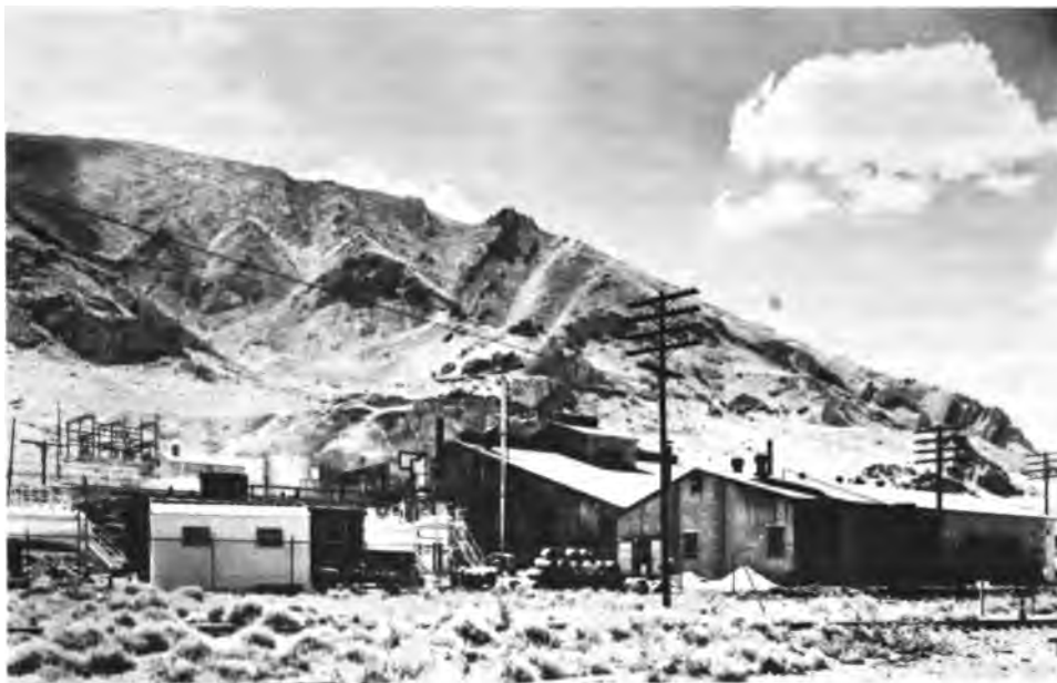
Figure 2. Photographie de la raffinerie de cobalt et de cuivre à Garfield, Utah.
