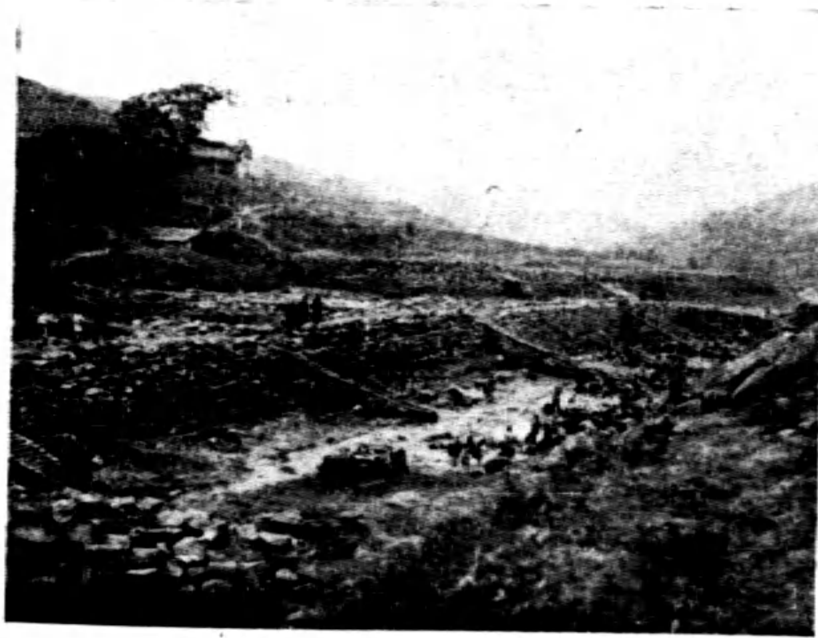
甲 初開工時修築擋水壩及清底
