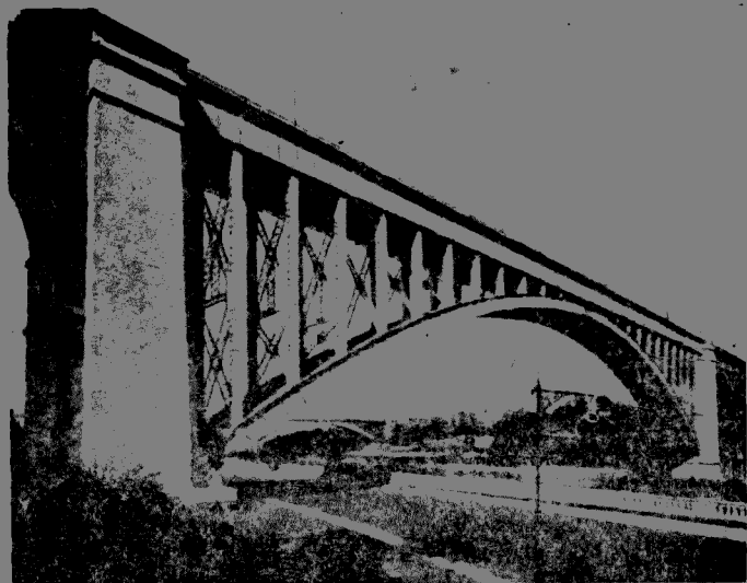
影片 XVI. 三鐵版電機房拱橋
