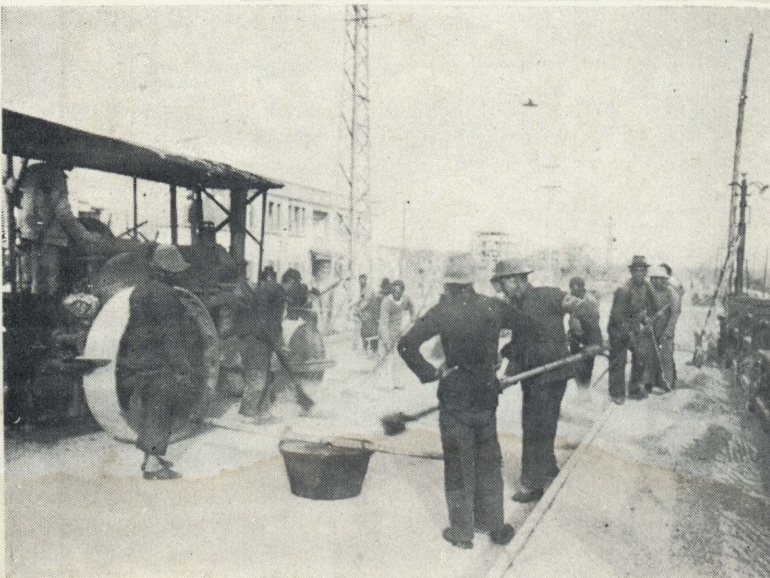
鋪澆逸仙橋橋面柏油時情形
