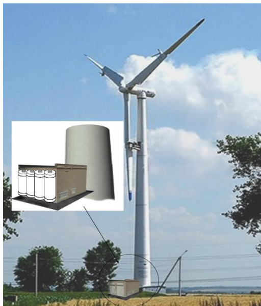
Рис. 4.10. Розміщення електролізної установки при компонуванні вітроводневого накопичувача енергії
