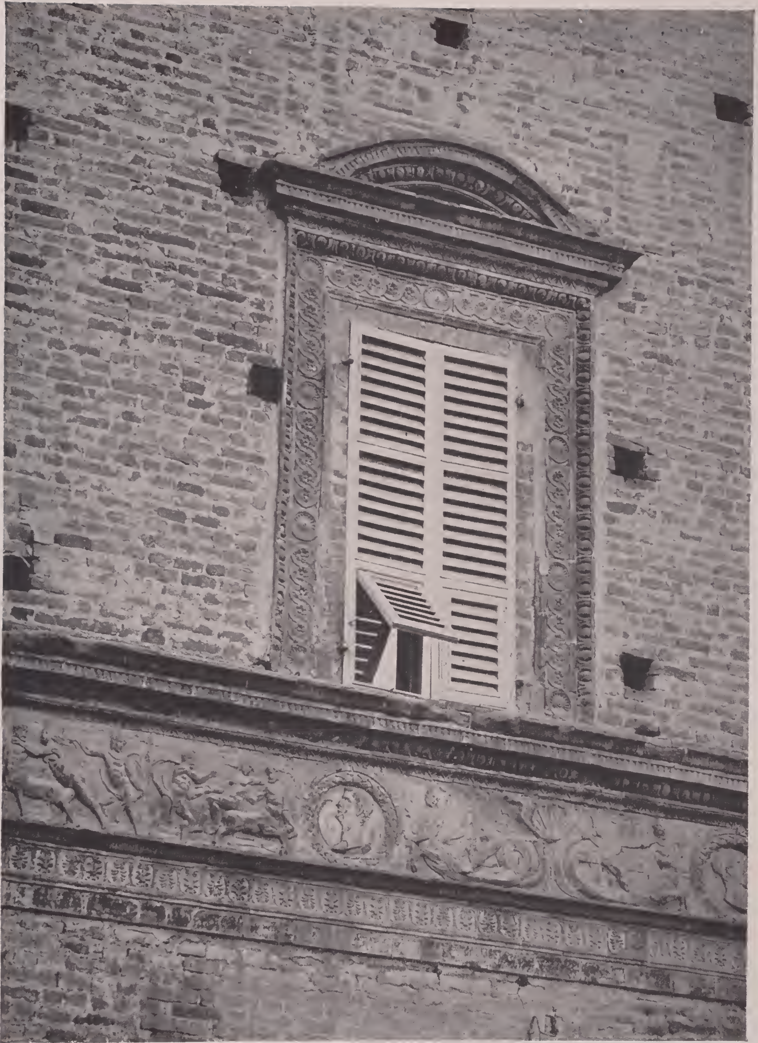
PIACENZA. PALAZZO DEI TRIBUNALE. Terra cotta frieze and window trim by Giovanni Battagio.
