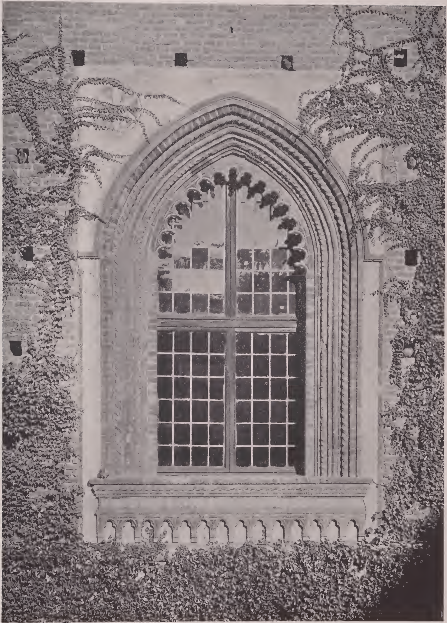
MILAN. CASTELLO SFORZESCO. A Gothic window in brick and terra cotta.
