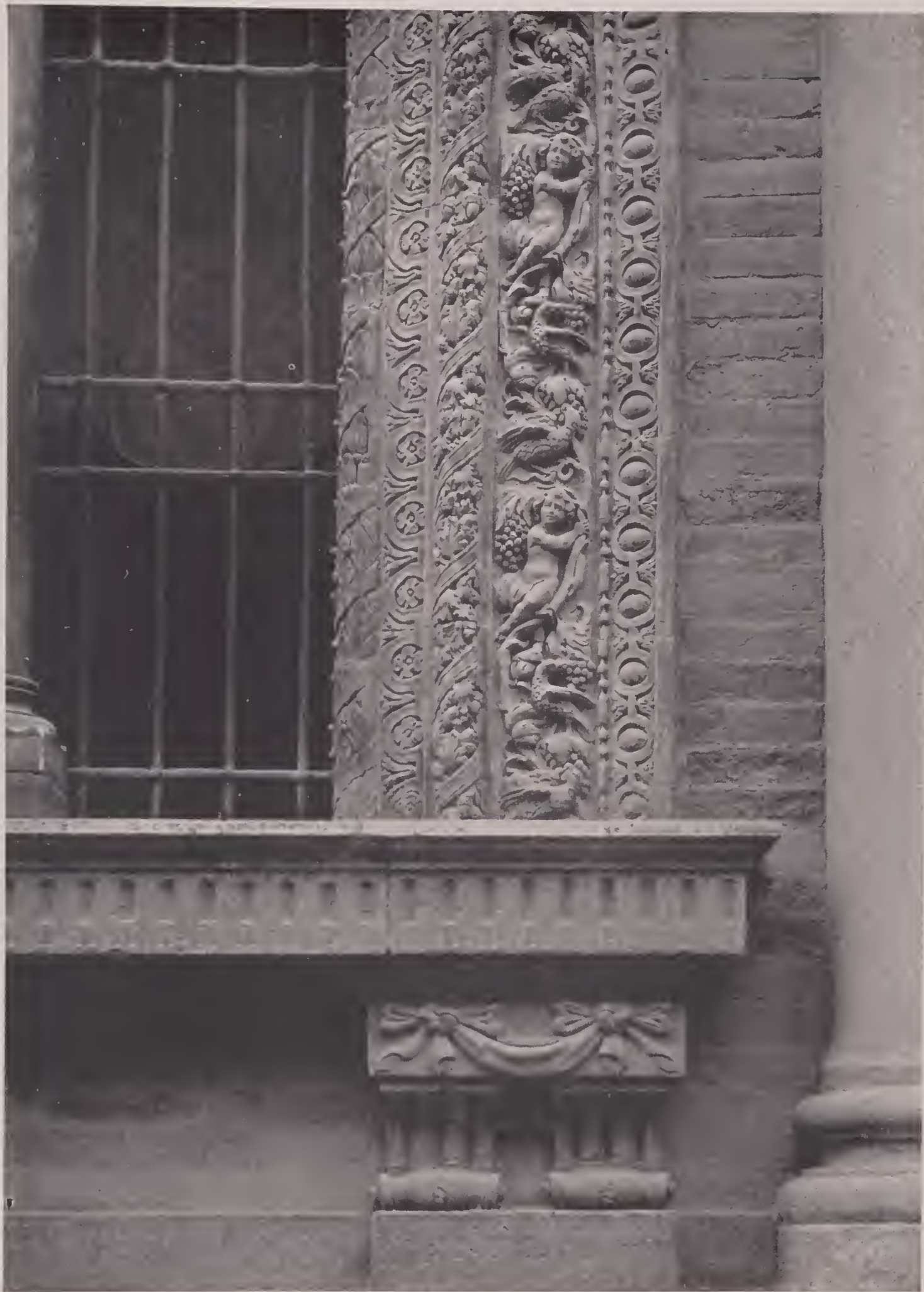
MILAN. OSPEDALE MAGGIORE. Large detail of terra cotta window architrave.
