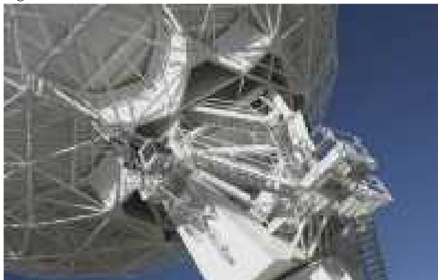
Detailansicht der Konstruktion (Foto: Keith Stanley)
