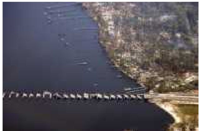
31. August: Eine komplett zerstört Brücke
