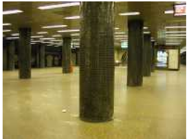
Station Kossuth Lajos tér der Linie M2 (Foto: Peter Gerecs)
