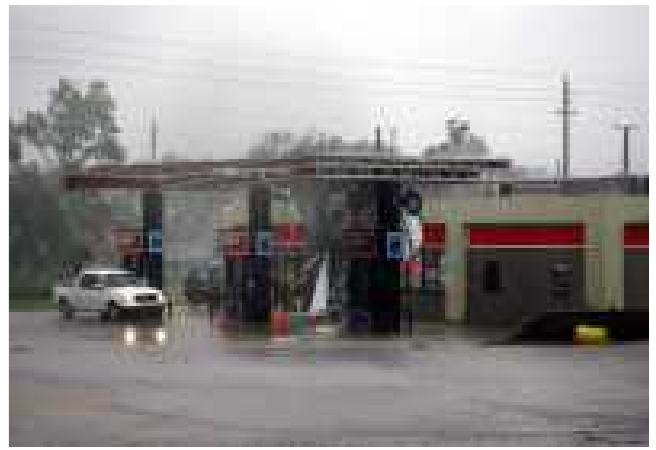
29. August: Auch ohne Dach ist die Tankstelle noch geöffnet
