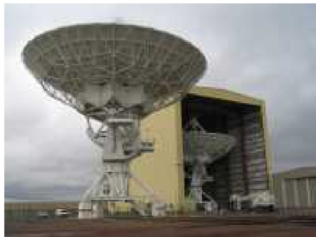
Bei Windstille können die einzelnen Teleskope auf Schienen in die Reperaturhalle gefahren werden. (Foto: Daniel Schwen)
