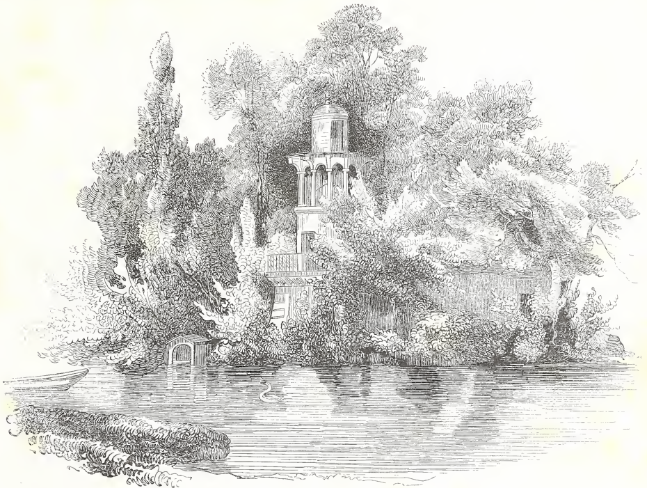
Tour de Marlborough, côté de la pièce d'eau.
