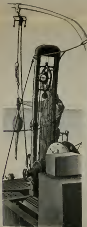
4. Die Sigbee'sche Lotmaschine
