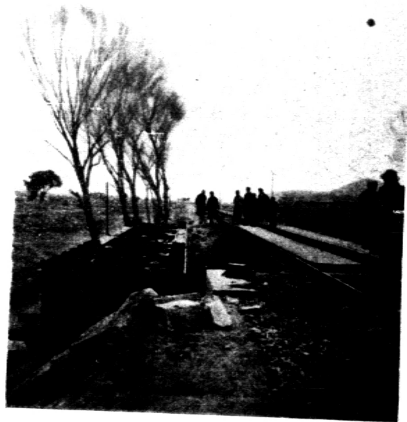
(35) 小溝河新橋落成
