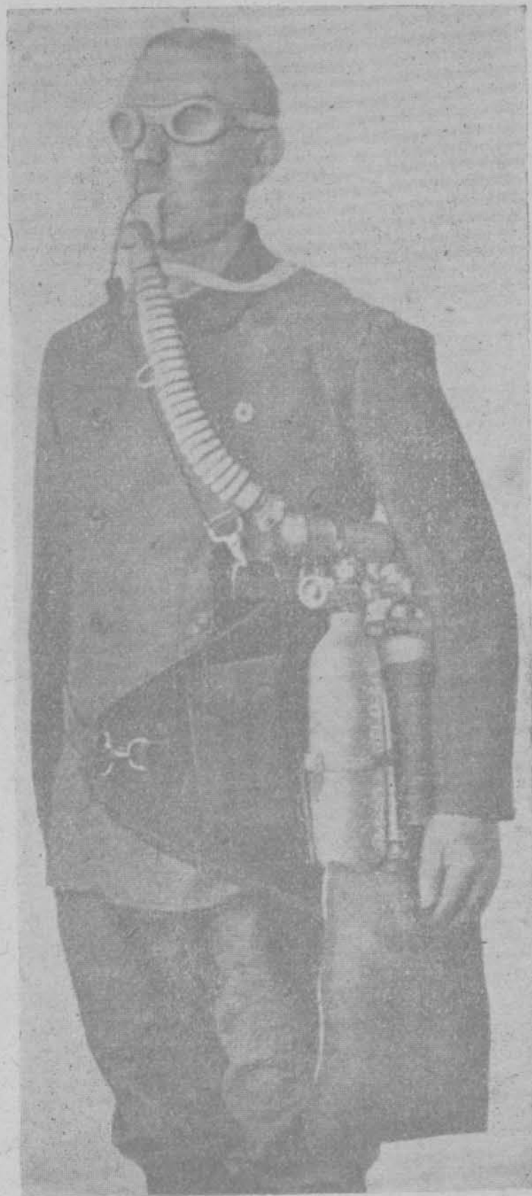
附圖 44. 1915 年德國軍隊用之 樞革 H.S.S. 式氧氣防護器具(Deutsches Heeres-Sauerstoffschutzgerät, H. S. S.-Gerät nach Dräger),曾在大戰時使用之者。
