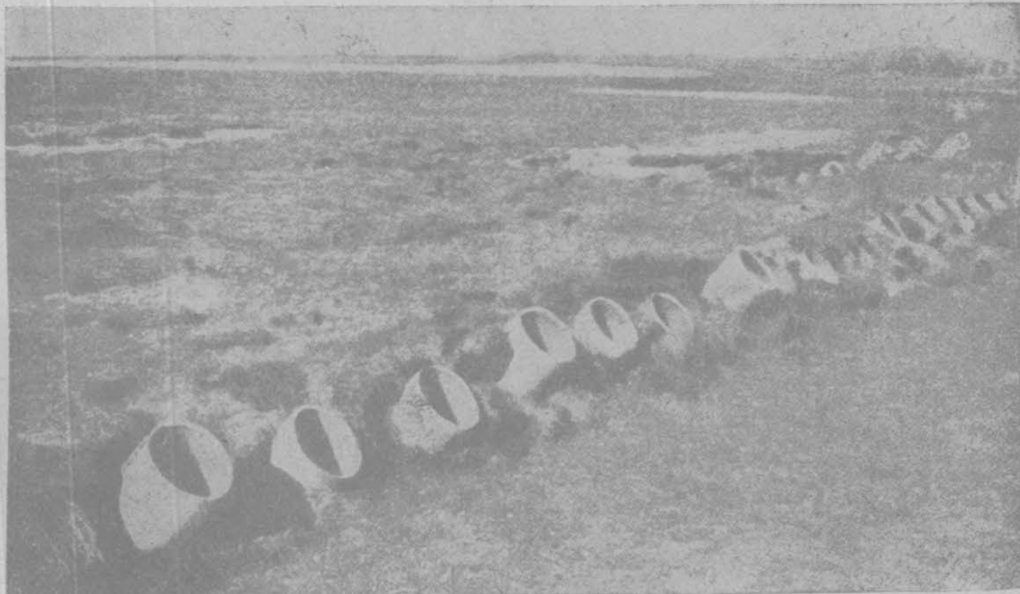
附圖 12. 埋好的英國式投射砲〔即利文式投射砲 (Livens Projector)〕。
