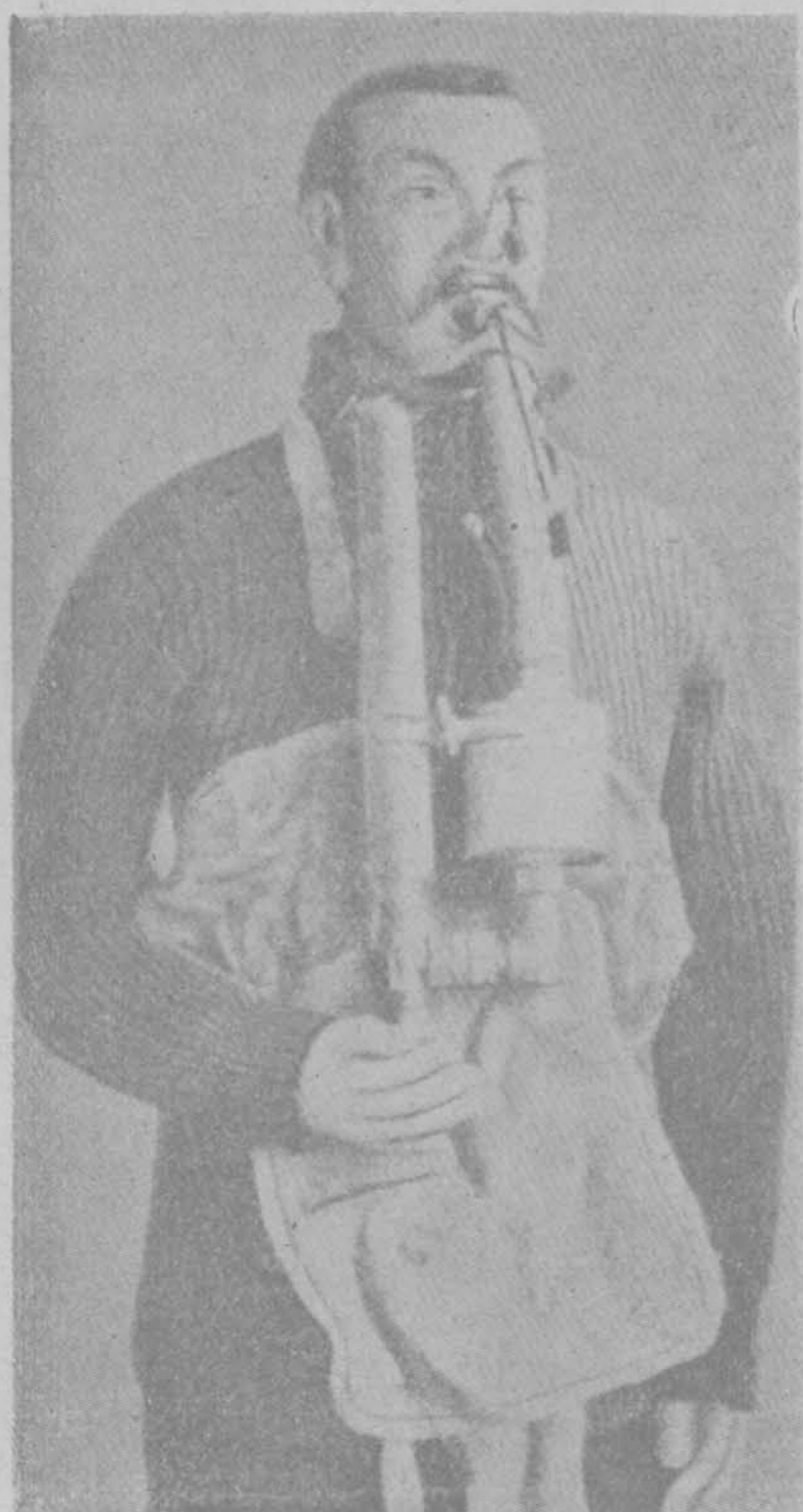
附圖 60. 按照 德國 椎革 (Dräger) 模型自救器 (Selbstretter) 在 法 國建造而曾於大戰時使用之 法 國式自救器。(參觀第286-7頁)
