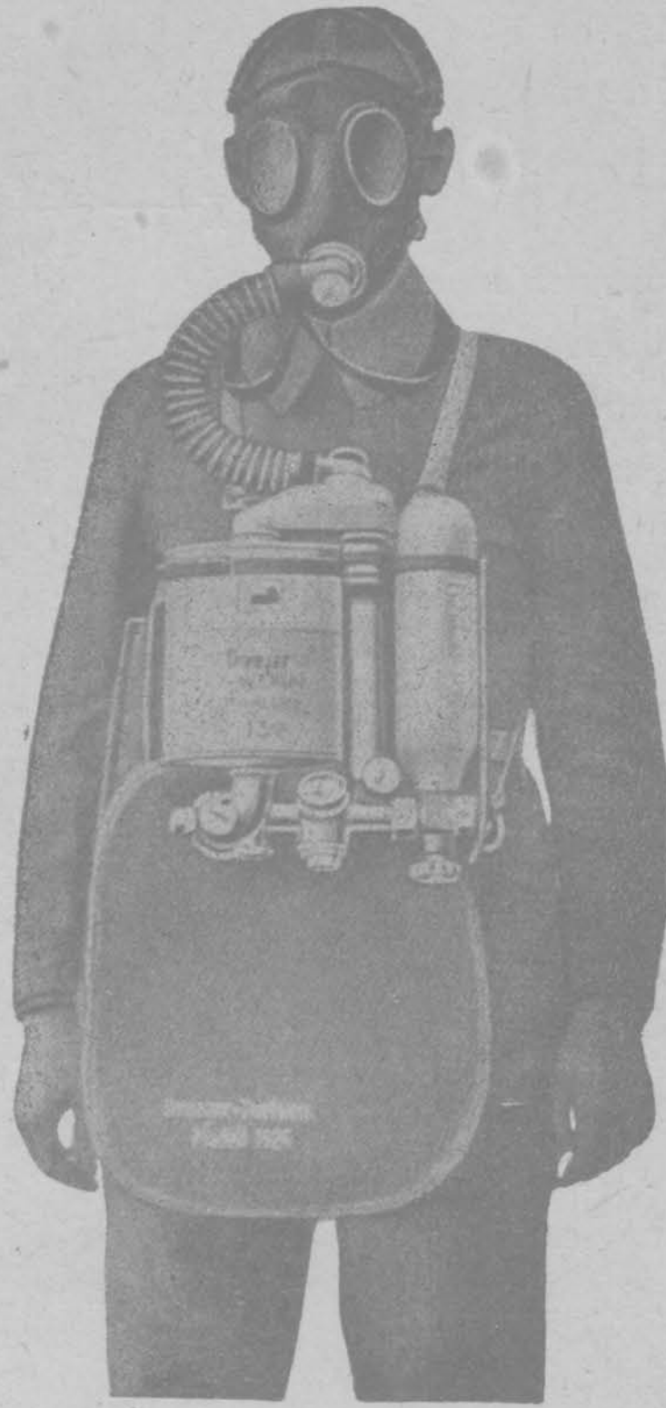
附圖 41. 德國之椎革士奔式 自救器 (Selbstretter nach Dräger-Tübben)。1924年 之模型。
