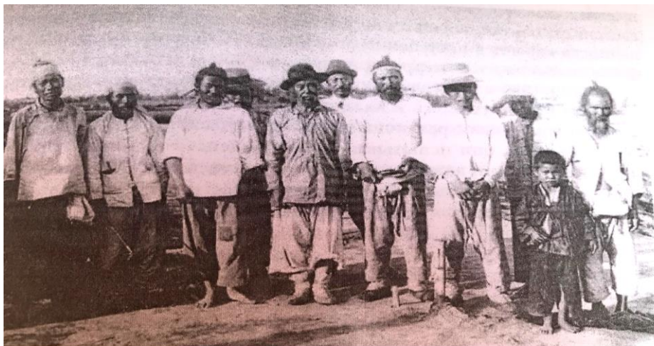
Группа корейских рабочих на строительстве Уссурийской железно дороги. Около 1896 г. Аналогичные группы создавались и для прокладки линии связи на побережье Камчатского полуострова . 1910 - 1913 гг. (Из коллекции Ж.Г.Сон)
