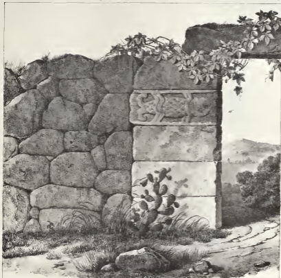
Figura 1. — Vista de la pared.
