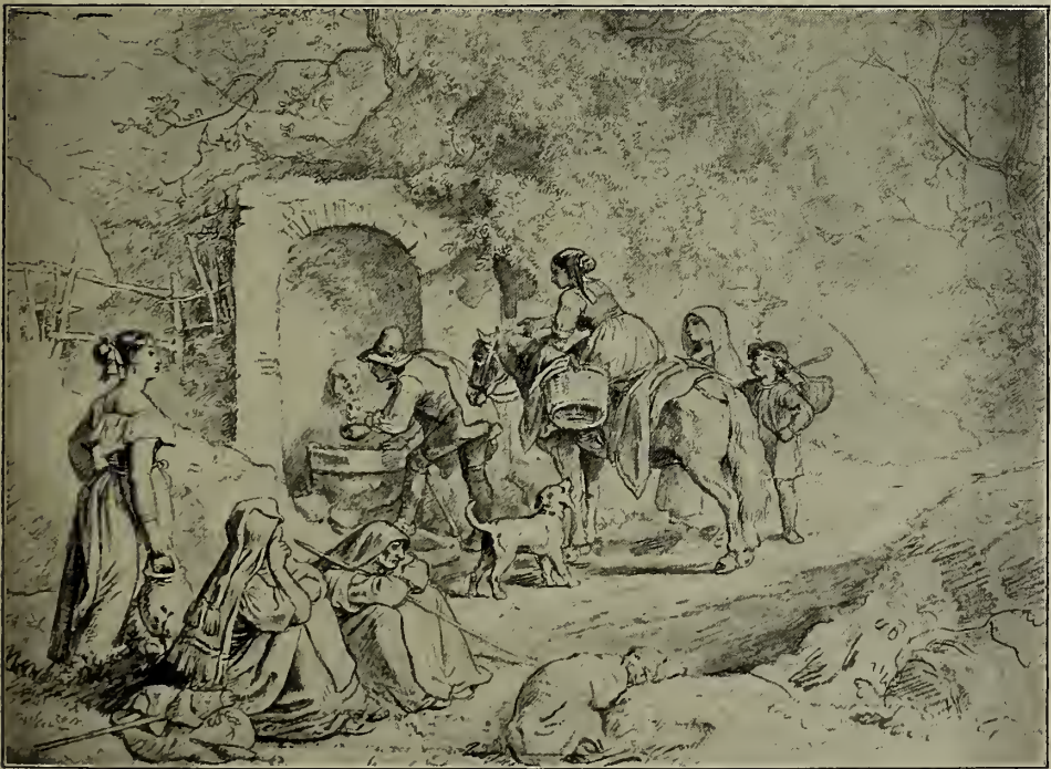
Abb. 162. Brunnen bei Ariccia. Nach einer Originalphotographie. (Zu Seite 88.)
