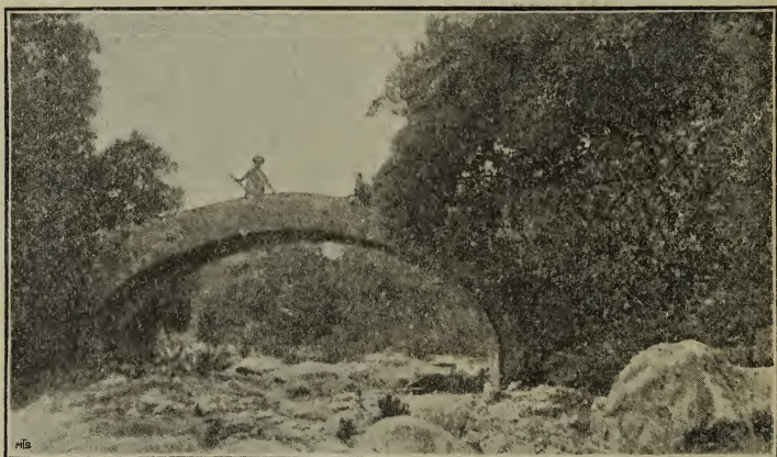
Ponte sulla Fortulla nel bosco del Fortullino.
