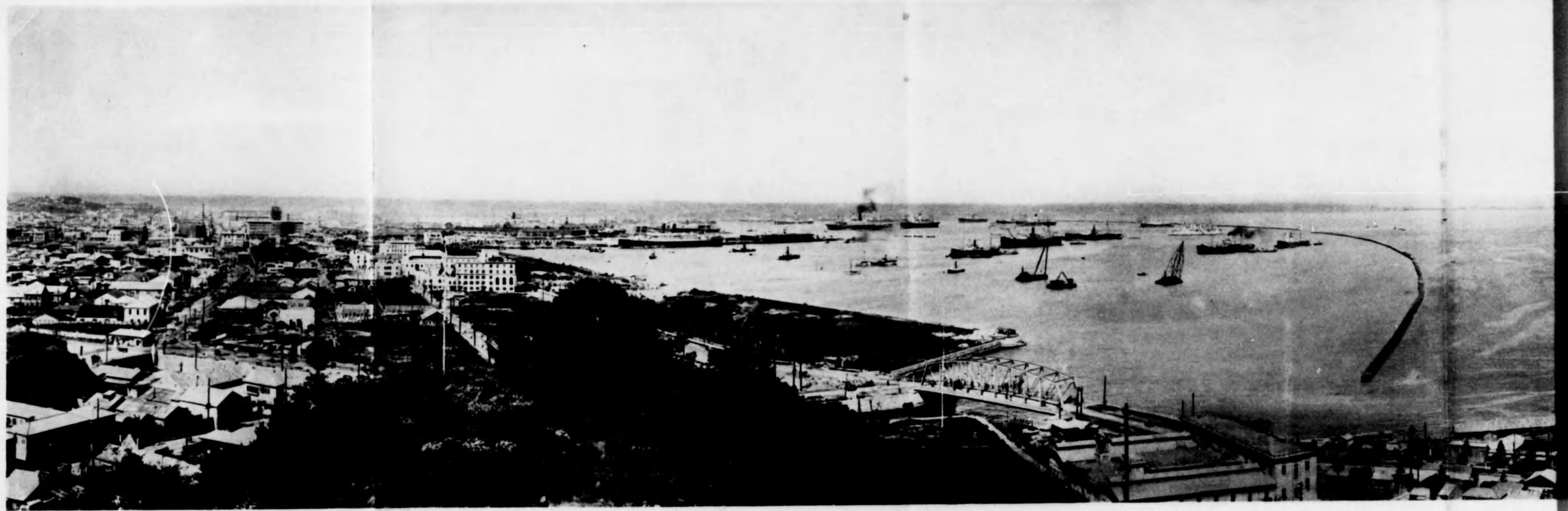
(昭和三年十月録影) 船泊信號所望樓より港内を望む
