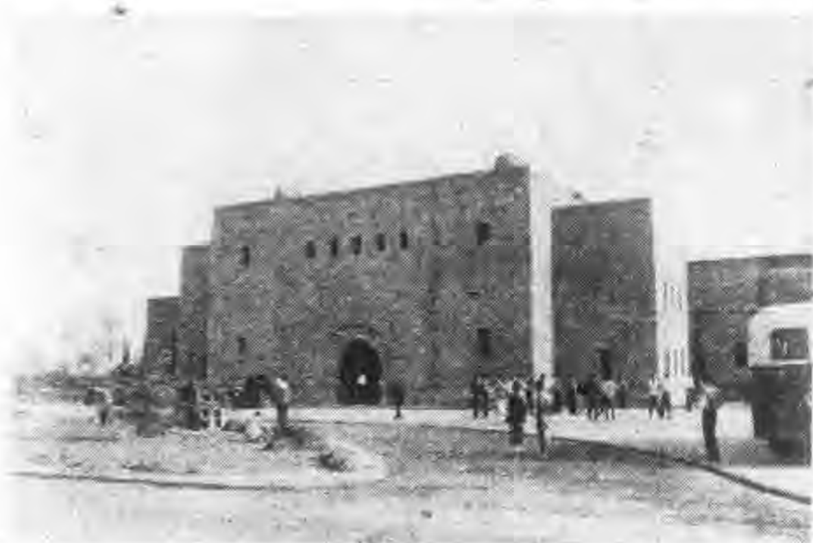
已修葺完竣之遊泳池大門
