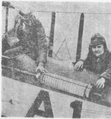
第二一五圖 飛行減聲器之裝置
