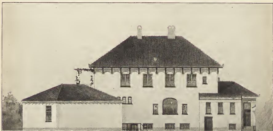
VILLA I SKJOLDSGADE.
