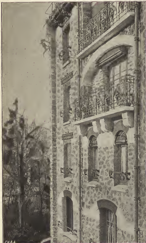
DEL AF FAÇADEN.
