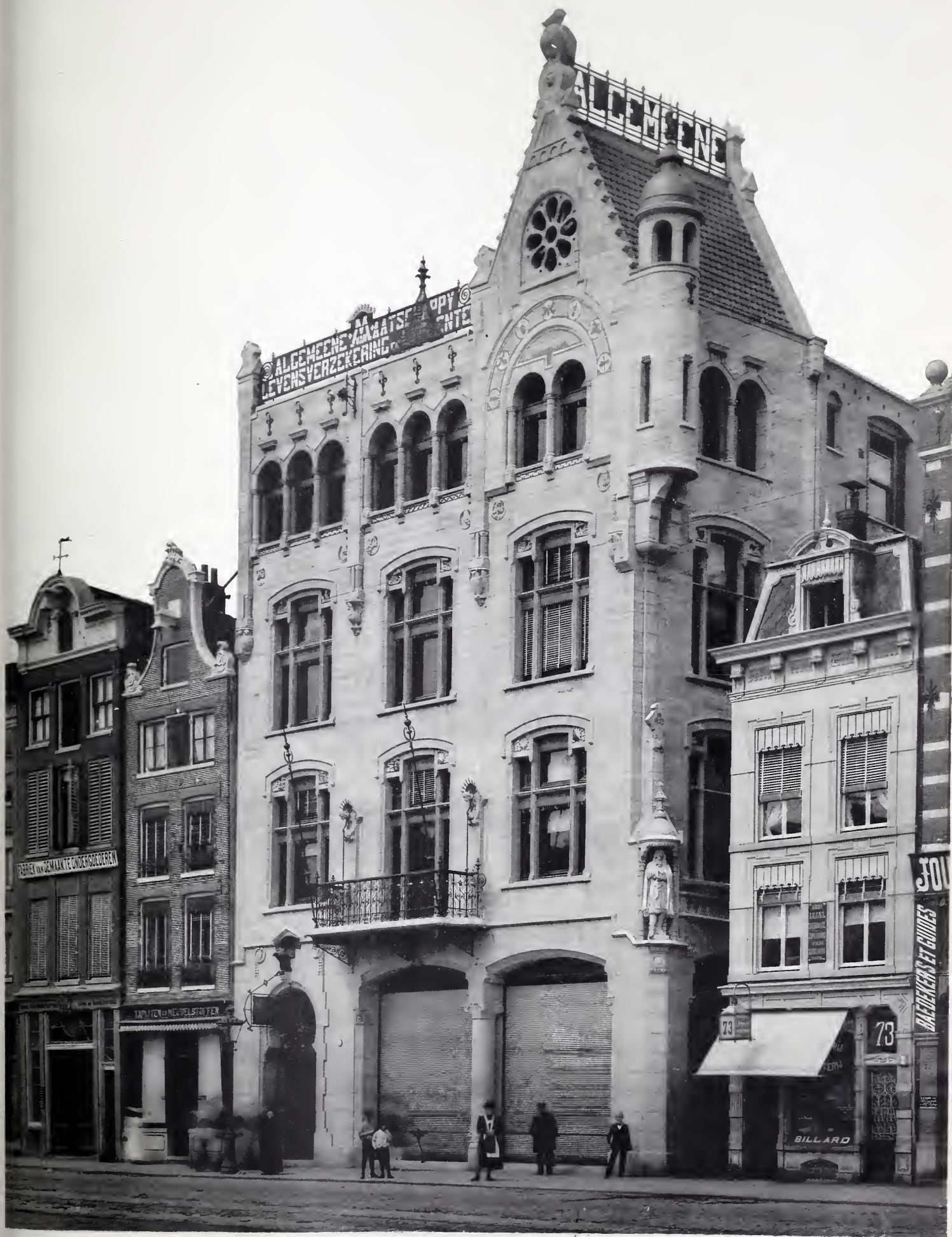
KANTOORGEBOUW DER ALGEMEENE MAATSCHAPPIJ VOOR LEVENSVZERZEKERING EN LIJFRENTTE, TE AMSTERDAM.
