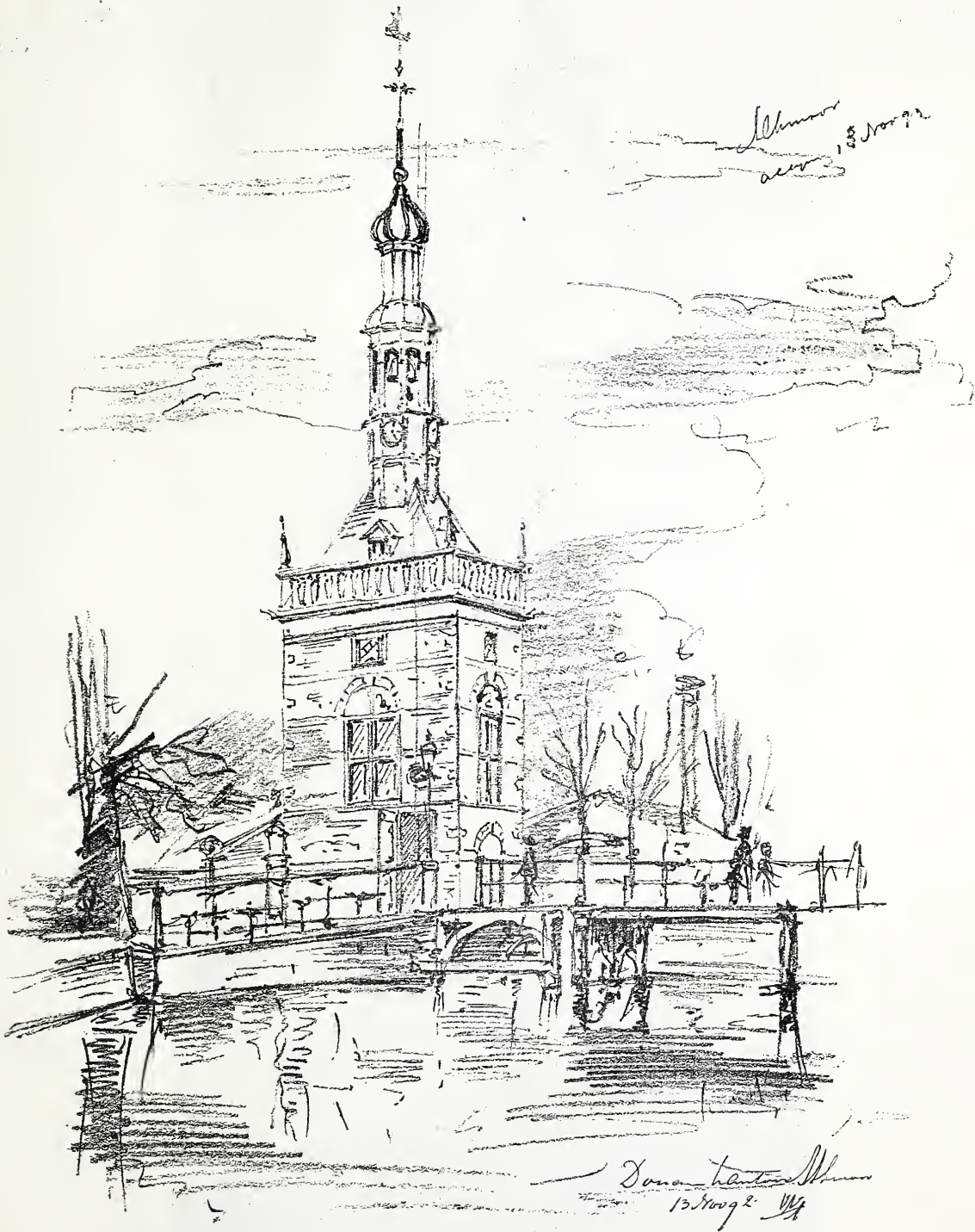
HET DOUANEN-KANTOOR TE ALKMAAR.
