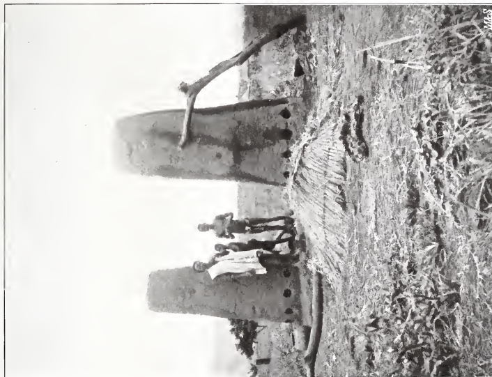
Fig. 2. Hochöfen der Eingeborenen beim Dorfe Biagbawa. Im Vordergrund ist die ausgebrachte Eisenrinne sichtbar und dicht dahinter das Strohdach, welches dem Ofen während der Zeit des Nichtgebrauchs aufgesetzt wird.
