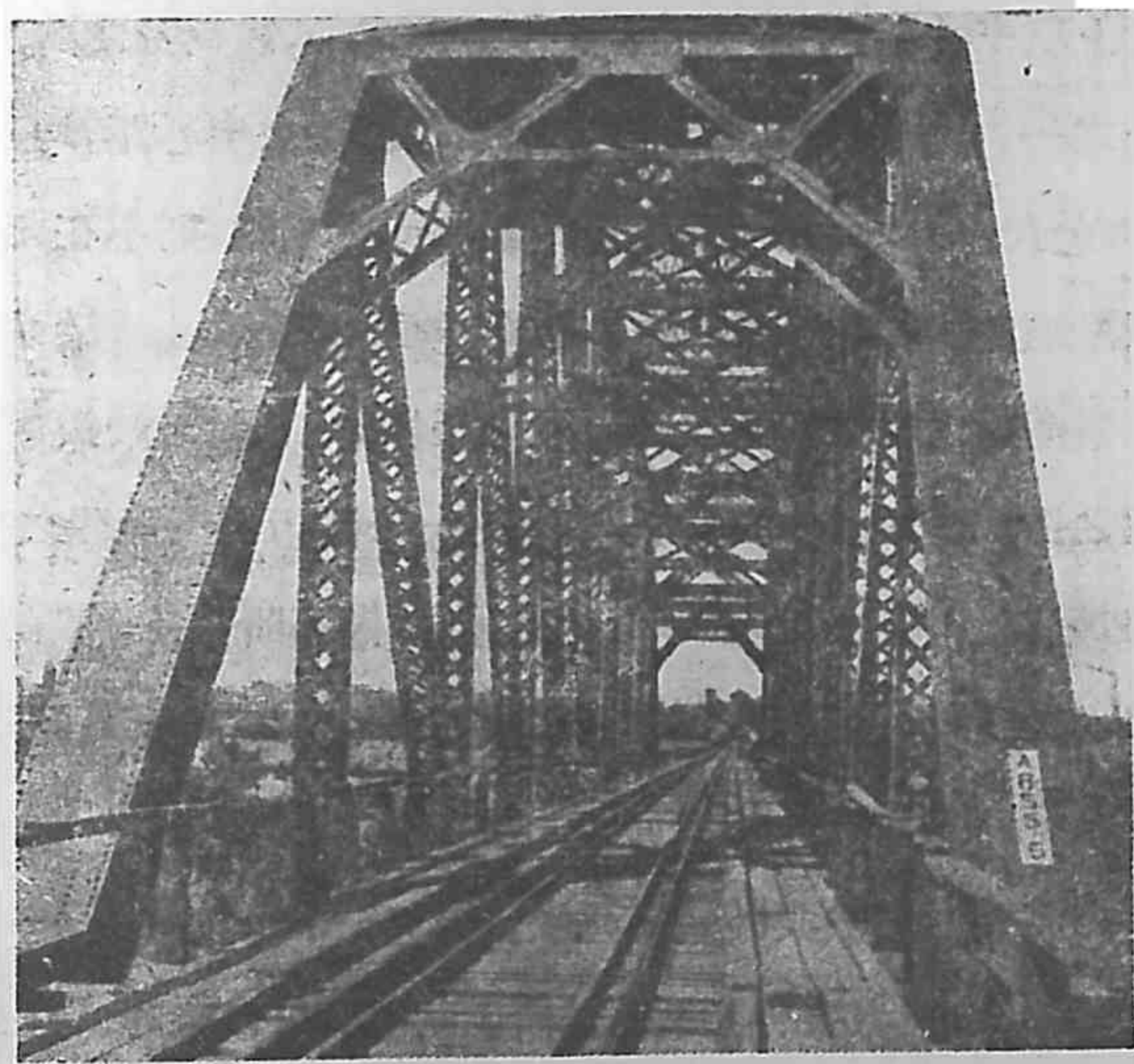
影片 IX. 穿越式桁架橋
