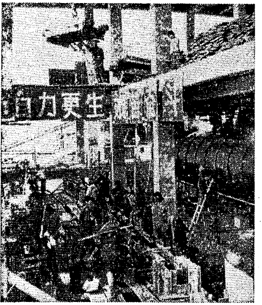
原料车间工人自力更生建造二十四平方米烧结机。 本报通讯员、本报记者摄
