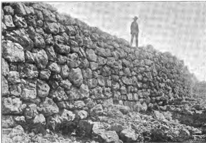
Hauptwall des Castellaras de la Malle.
