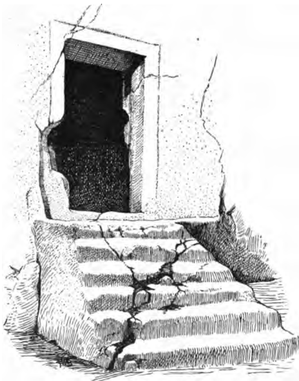
Eingang (Thür-Oeffnung) zu den „Todten-Kammern“.
