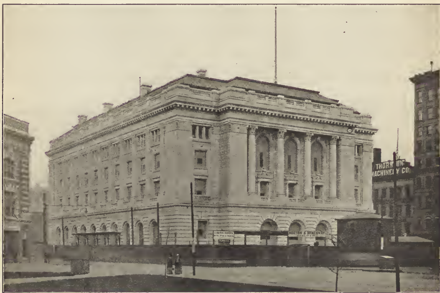
POST- OG TOLDBYGNING I PROVIDENCE.
