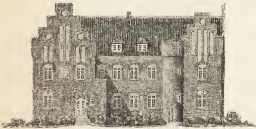
KOTTAGENS ENE SIDE.
