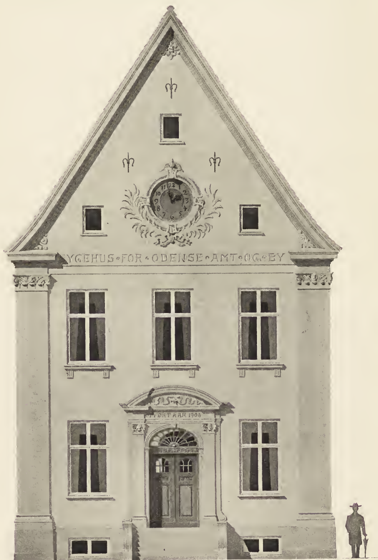
SYGEHuset i Odense. Midtparti af Kirurgisk Afdeling. ARCHITEKT J. LAAGE.
