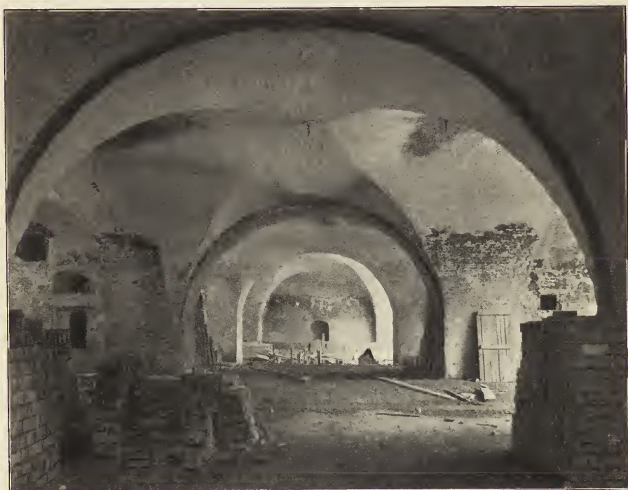
HVÆLVINGSRUM I DEN GAMLE GALEJBYGNING (NU AVISMAGASIN).
