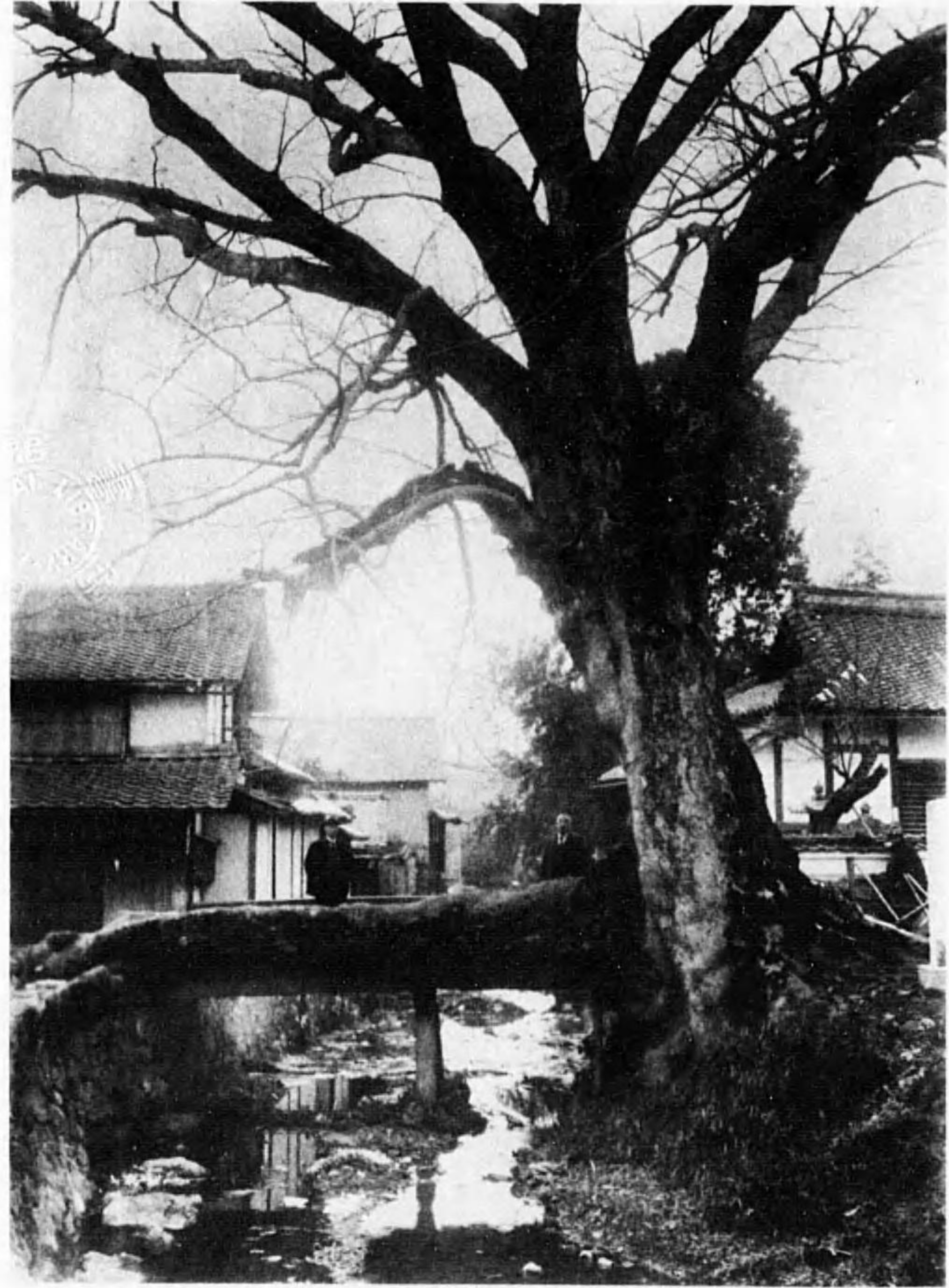
柏原八幡ノ木ノ根橋
