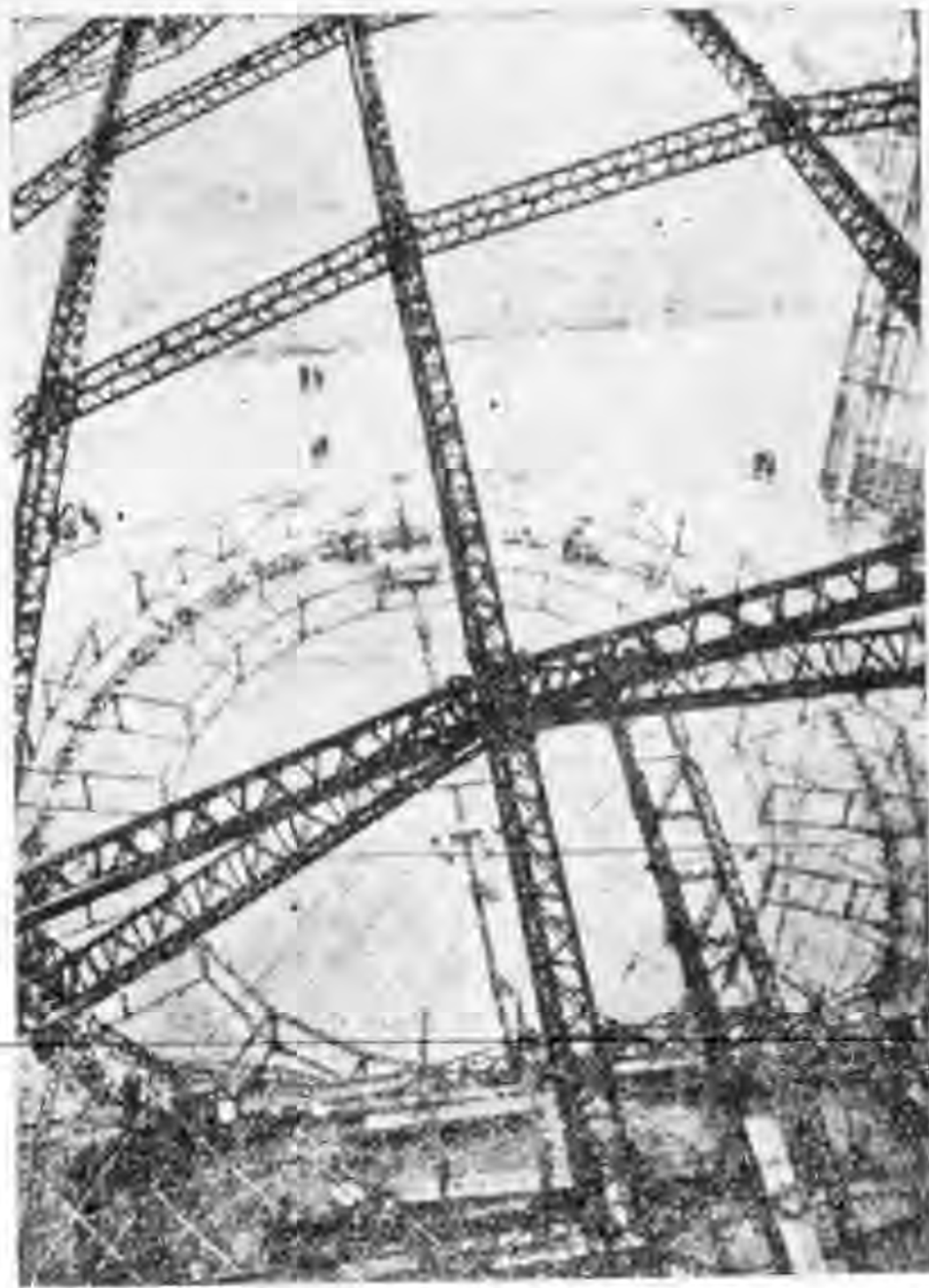
圖一 LZ129號鑲配骨架其巨大圓形鐵架安放地面將由起重機升舉配合之準備
