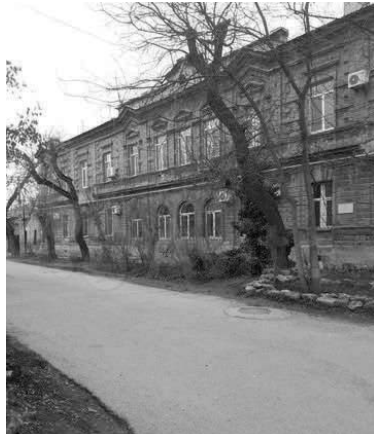
Будівля Євпаторійського караїмського ремісничого училища. Сучасний вигляд
