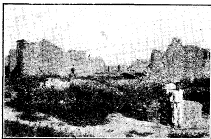
房屋拆散，農民無家可歸 (陝西永樂區)
