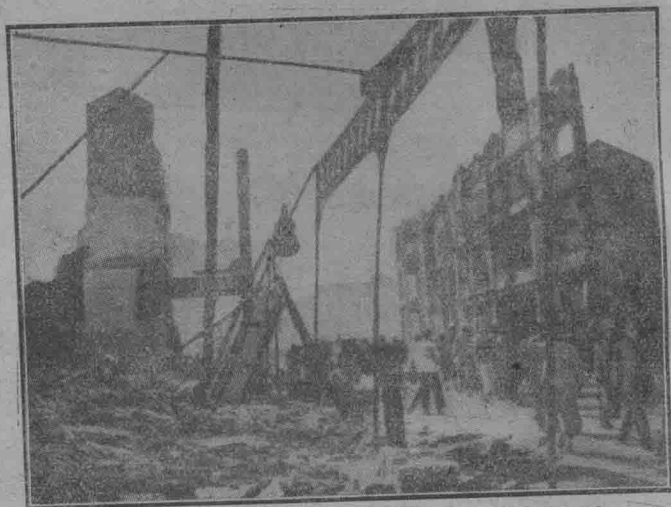
被火燒毀的房屋（火災必須消防，火險必須妥保）
