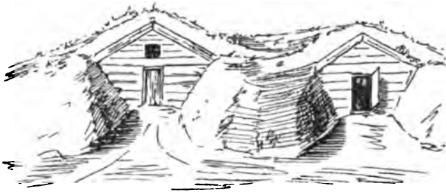
Eingebaute Erdhütte bei Ssysran vom Bergufer aus.
