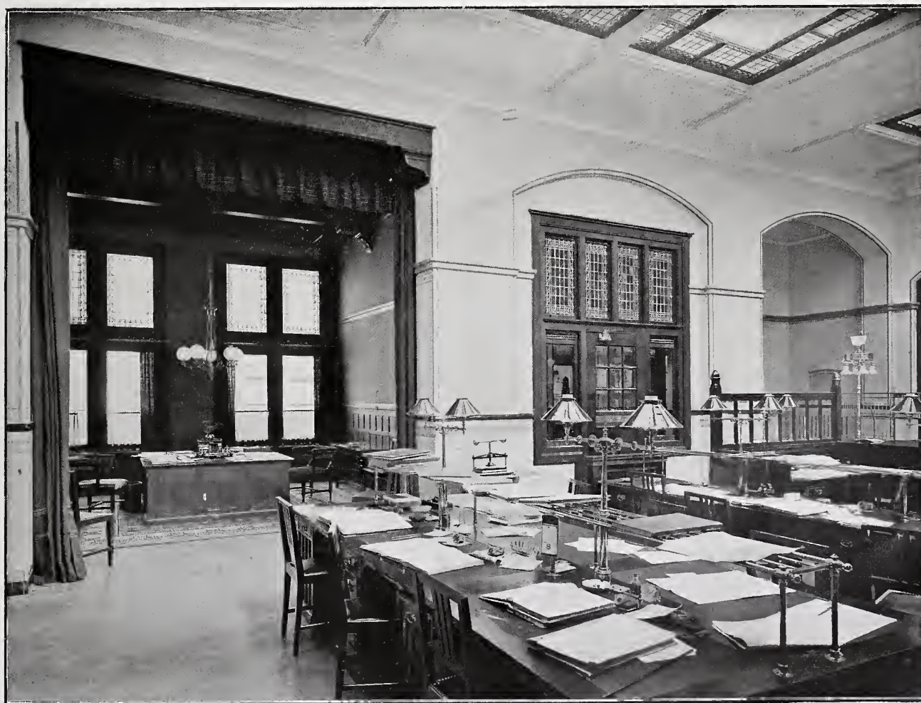
KANTOORLOKALEN IN HET BANKGEBOUW TE DORDRECHT. Architecten Gebrs van GENDT A.LZN.
