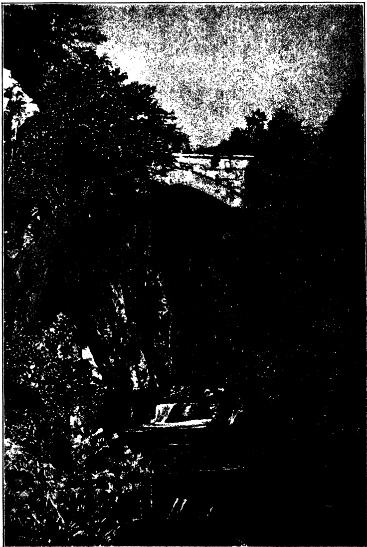
Alte Brücke über die Žepa.
