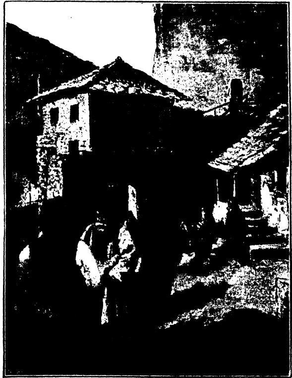
Im Brückenviertel von Mostar.
