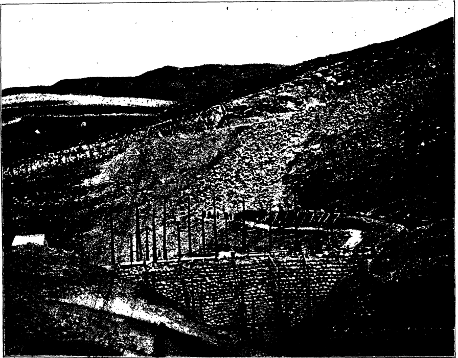
Arbeiten an der Kline bei Gacko.
