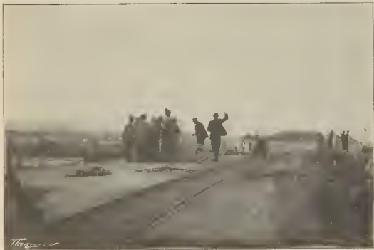
Preparativos para restablecer la comunicación entre las dos partes del puente sobre el Besós, en la carretera de Barcelona á Mataró, aisladas por la cortadura del terraplén
