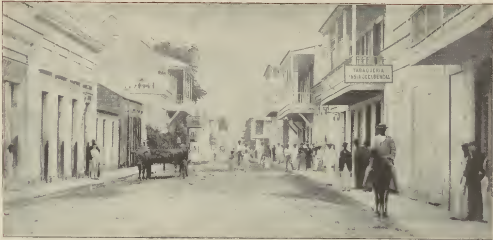
VISTA DE LA CALLE QUE CONDUCE AL MUELLE
