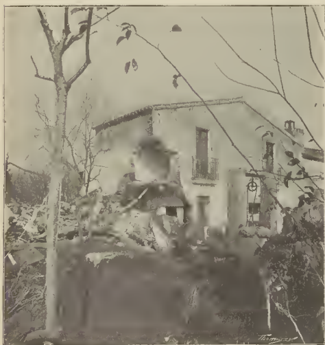
Casa conocida por «Canaillas» que ha sufrido grandes desperfectos
