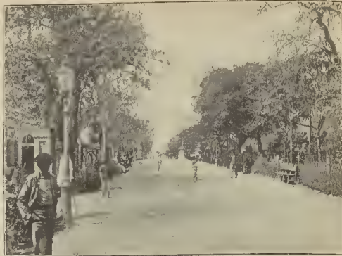
SAN JUAN DE PUERTO RICO. - Paseo del Príncipe (de fotografía)
