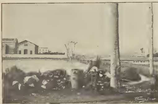
Depósito de las aguas del Llobregat que surten á Barcelona, aislado desde los primeros momentos
