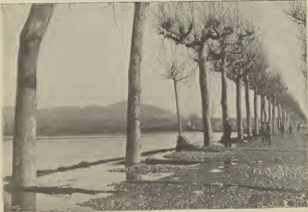
Trozo de la carretera de Barcelona á San Baudilio durante el descenso de las aguas
