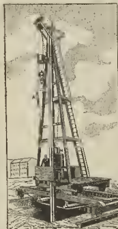
Martinete para fundaciones rápidas en un suelo flojo. - A. Cono de hierro fundido de 1,500 kilogramos de peso, que elevado por una cabina de vapor M, cae automáticamente desde una altura de 10 metros y abre pozos que luego se llenan con betón para consolidar el terreno.
