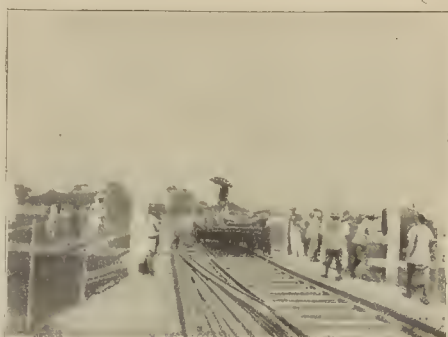
Fig. 2. - Construcción de los 100 metros últimos de vía
