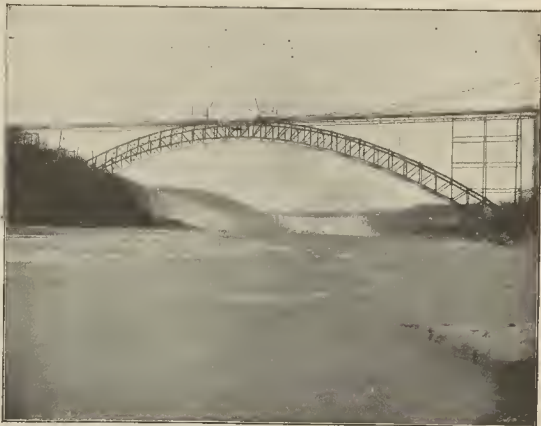
Fig. 2. - El nuevo puente sobre el Niágara. El arco del puente nuevo completamente terminado
