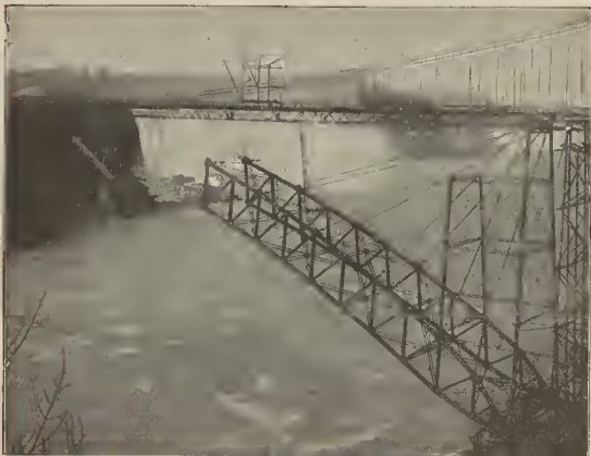
Fig. 1. - El nuevo puente sobre el Niágara. Construcción del arco debajo del antiguo puente colgante
