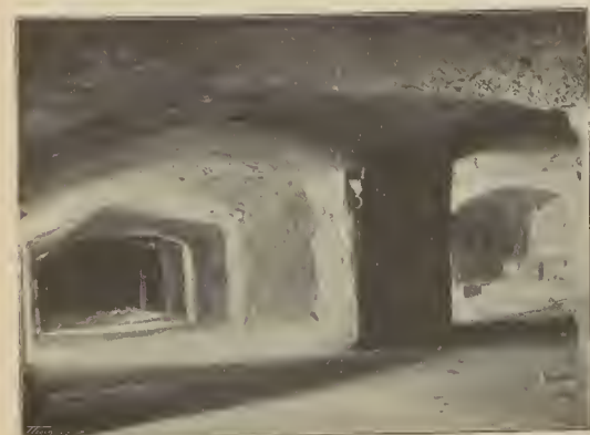
MINA SUBTERRÁNEA DEL DERRUIDO CASTILLO DE SAN FELIPE, DE MAHÓN, de fotografía de D. José Baltá de Cela, de Barcelona, premiado con un accésit en el concurso de LA ILUSTRACIÓN ARTÍSTICA
