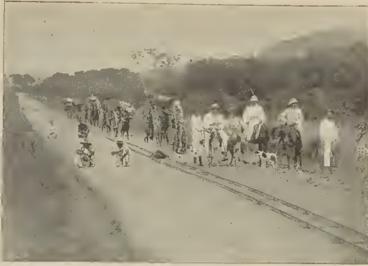
EL FERROCARRIL DEL CONGO. - Los primeros trabajos (de fotografía)
