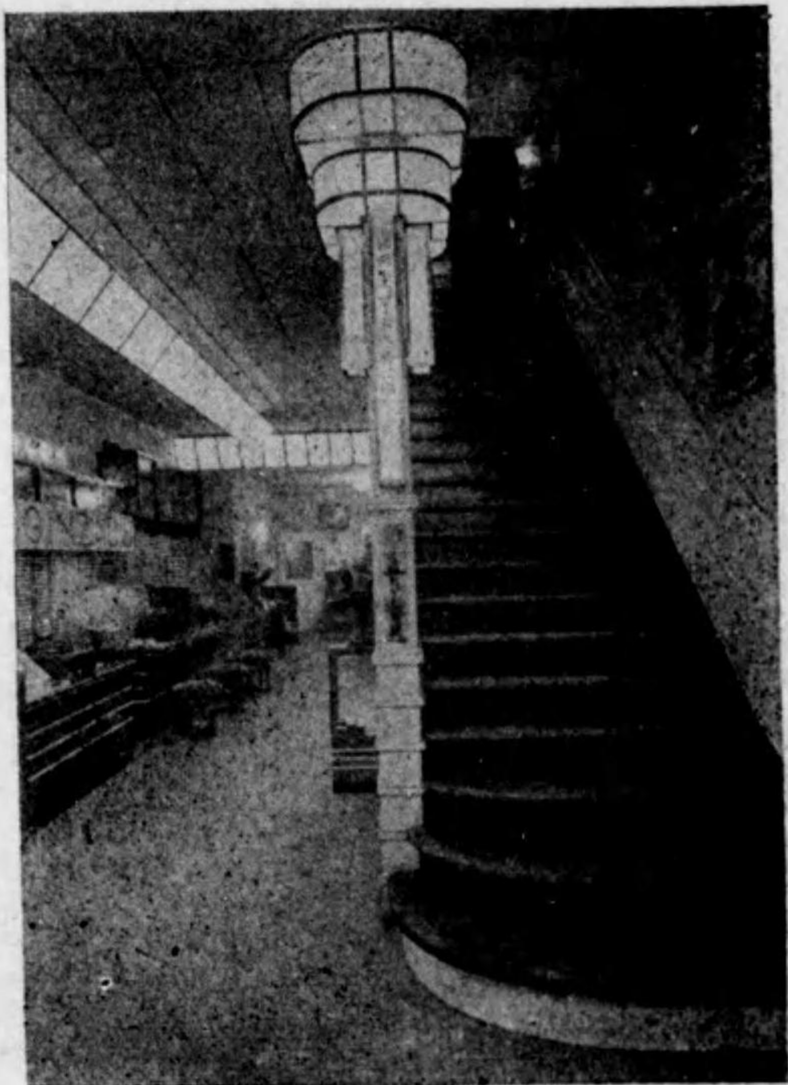
建築化照明の實例
