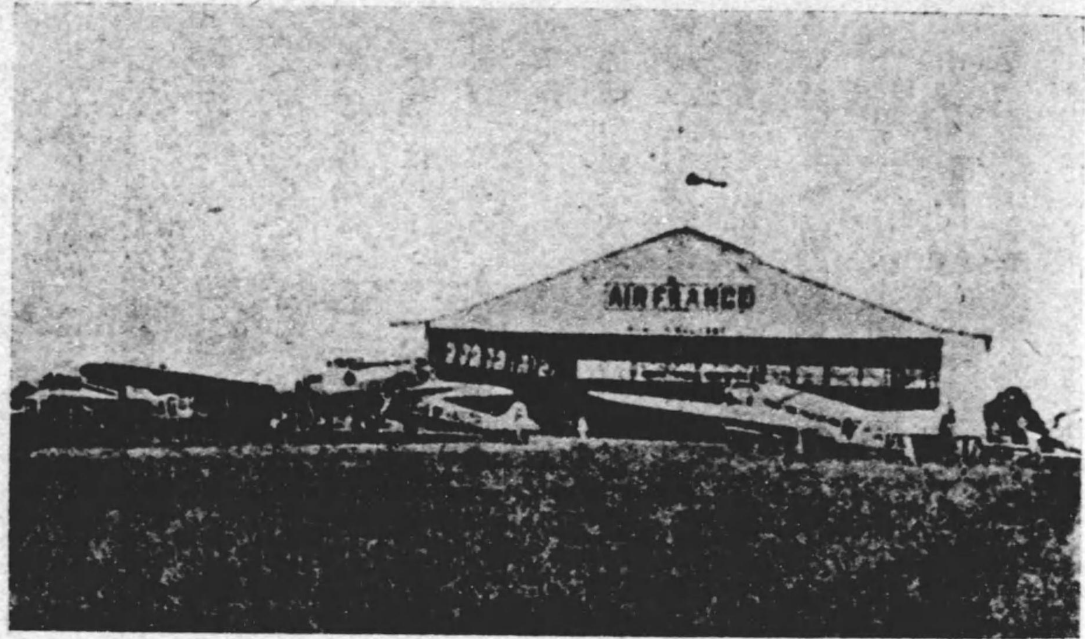
河内デア・ラム航空港 (エール・フランス會社格納庫)
