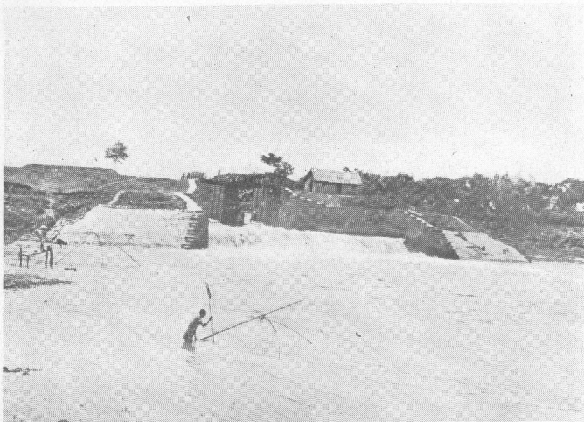
14 金雙閘為調節運河鹽河之水量而設，圖示此閘啓放時運水注入鹽河湍急奔放之狀。
