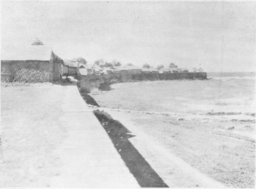
9. 洪湖大隄岸，係用大石疊建，且多蜿蜒，以減水浪之沖擊力；此圖攝於高良澗附近。
