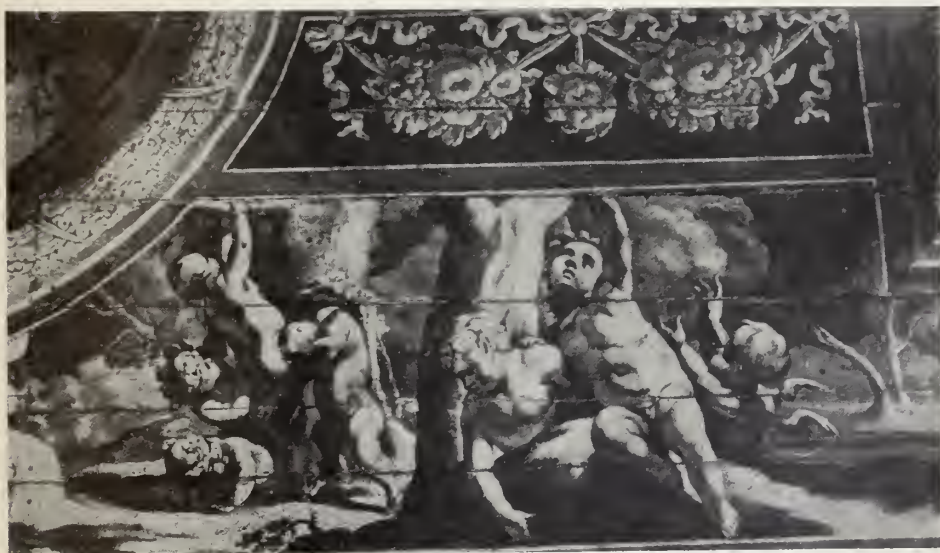
Schloß Mornay: Teil aus der Decke.
