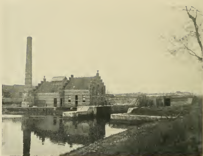
STOOMGEMAAL VAN HET AFVOERKANAAL.
