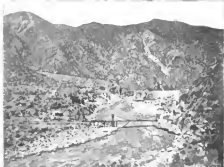
PUNTE DE LOS BAÑOS Y PUNTE PROXIMO
