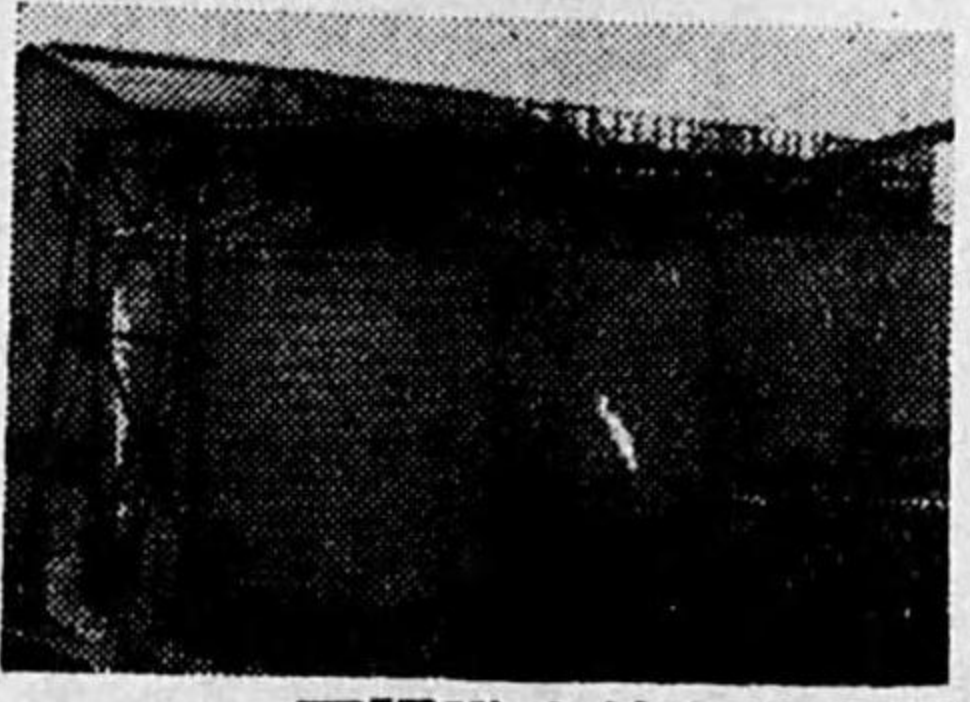
硫酸工場攪拌槽 (内径六米、深五米)
