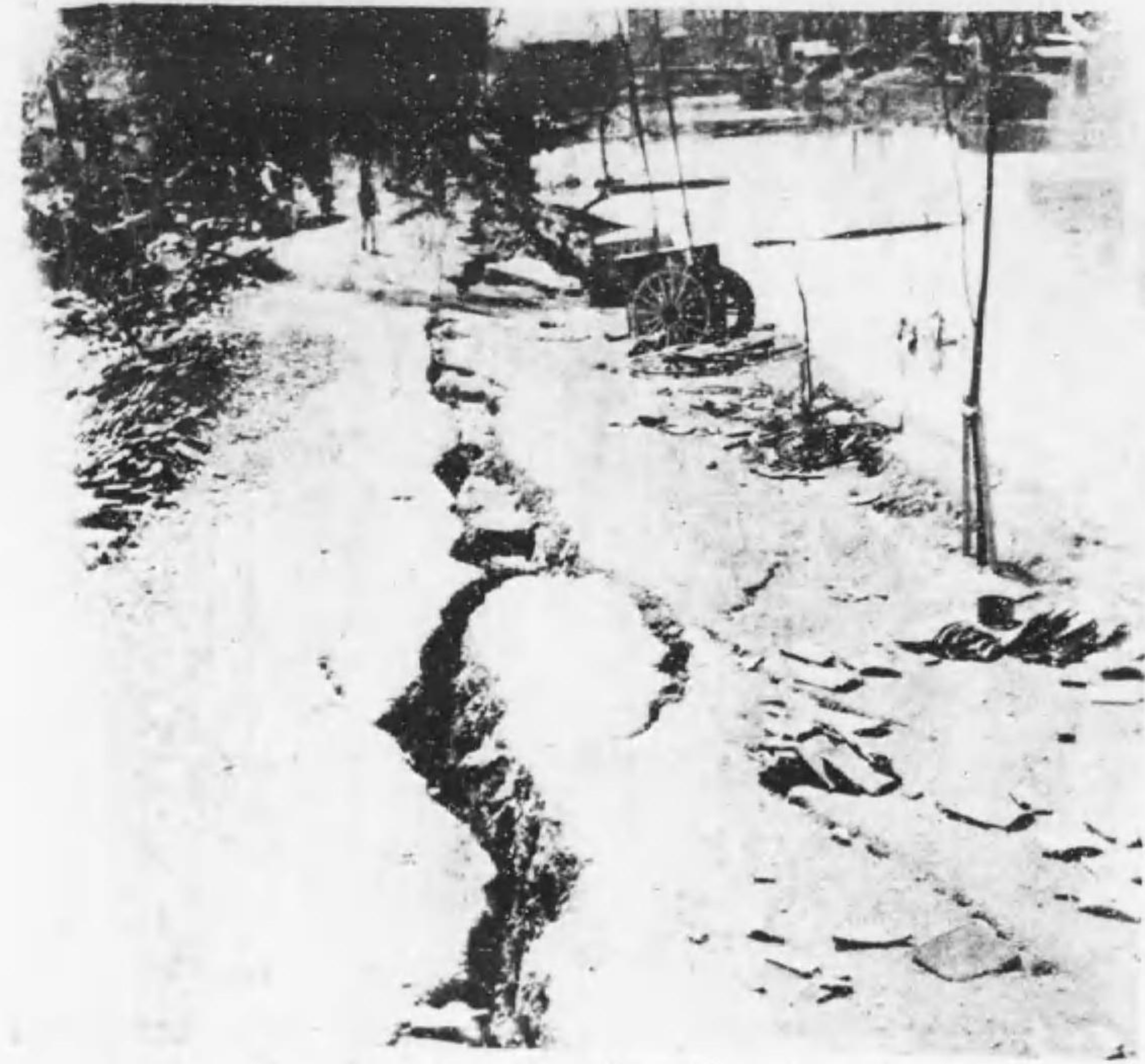
京地河津大橋
