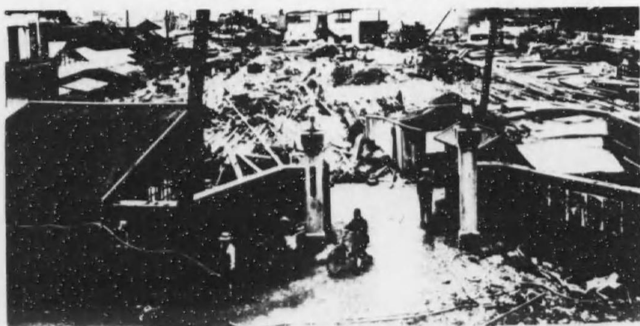
浦賀船渠社会工場の倒壊
