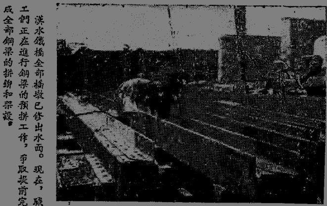
工們正在進行鋼架的預掛工作，爭取提前完成全部鋼架的掛架和安裝。
