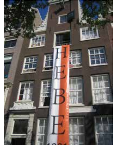
Nieuwe Herengracht 33 (Yeni Efendi Kanalı). HEBE evi, 18. yüzyıla ait, Amsterdam kanalının yanında tipik bir tüccar evidir. 1. kat ve 3. kat aynı zamanda depo kapılarıdır. Mal taşımak için binada bir vinç bulunmaktadır. Eski Amsterdam evleri arkaya doğru dar ve uzundur; çünkü ev ne kadar geniş olursa o kadar çok vergi ödemek zorundasınız.
