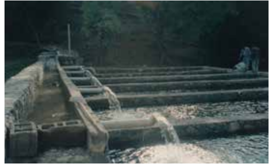
Birinci hasattan sonra alabalık üreticileri kendi kazançları ile toprak havuzları taş duvarla güçlendirdiler.
