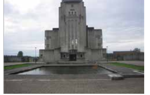
Annemin Hollanda'ya döndükten sonra radyo programı yaptığı Kootwijk'teki radyo binası. Bu binanın yanında 300 metre yüksekliğinde bir anten vardı. Bina 1920'li-30'lu yıllardaki Art-Deko mimarlık stilini yansıtıyor. Öndeki havuzun işlevi güçlü radyo akülerini soğutmak içindir. Binanın önünde Art-Deko sembolleri bulunuyor. Eski radyo binası günümüzde müze, konferans salonu, evlenme törenleri ve müzik konserleri amacıyla kullanılıyor.
