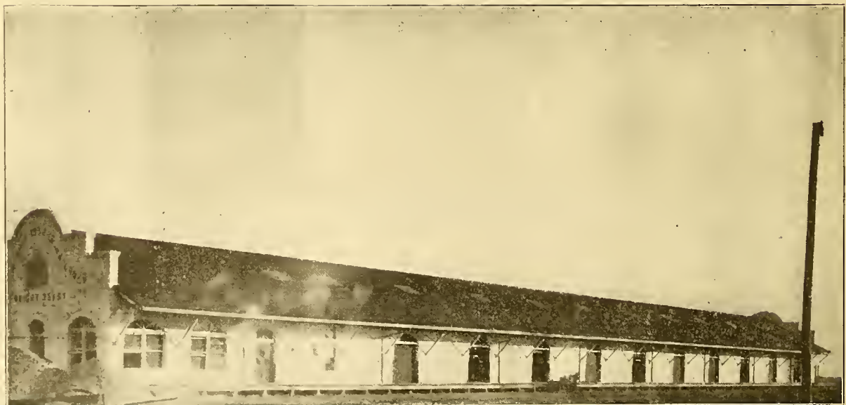
NEW G. & S. I. R. R. FREIGHT DEPOT AT GULFPORT.
