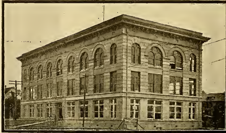
GENERAL OFFICE BUILDING G. & S. I. R. R.
