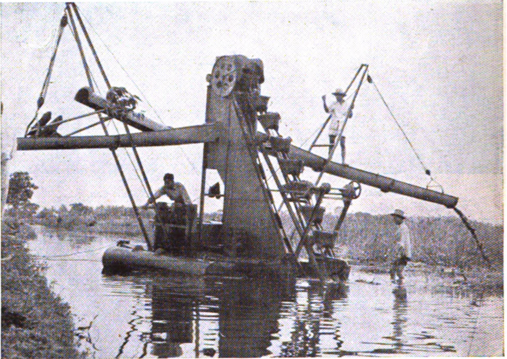
Untuk pembikinan persawahan di Kalimantan harus rawah-rawah jang mengandung air dikeringkan, karena itu dengan mesin kerok dipergunakan untuk memperdalam sungai-sungai dan pembikinan kanal.
