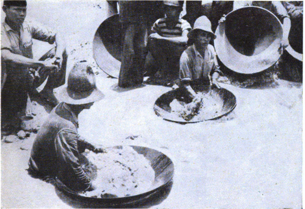
Bubur tanah jang bertjampur dengan batu kerikil dilinggang berangsur-angsur sampai bersih dari tanahnja.
