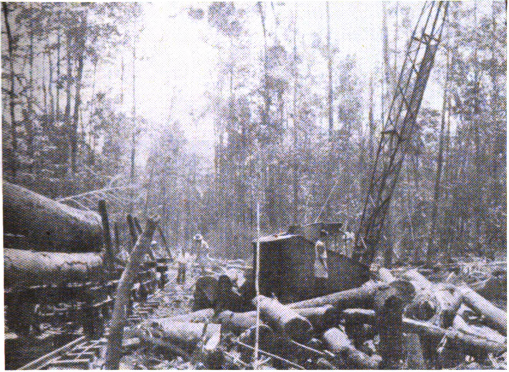
Batang-batang kaju jang besar dari pedalaman Kalimantan, dengan melalui rel dikirim ketepi sungai dan kemudian dirakit ke-penggergajian dsb. (Gambar 5, 6 dan 7).
