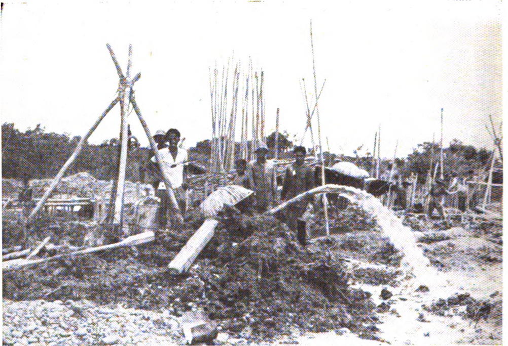
Djeradjak dari kaju dipakainja untuk menggali „Lobang dalam” jang dalamnja sampai 15 meter. Disamping itu djuga dipergunakan pompa air bermesin.
